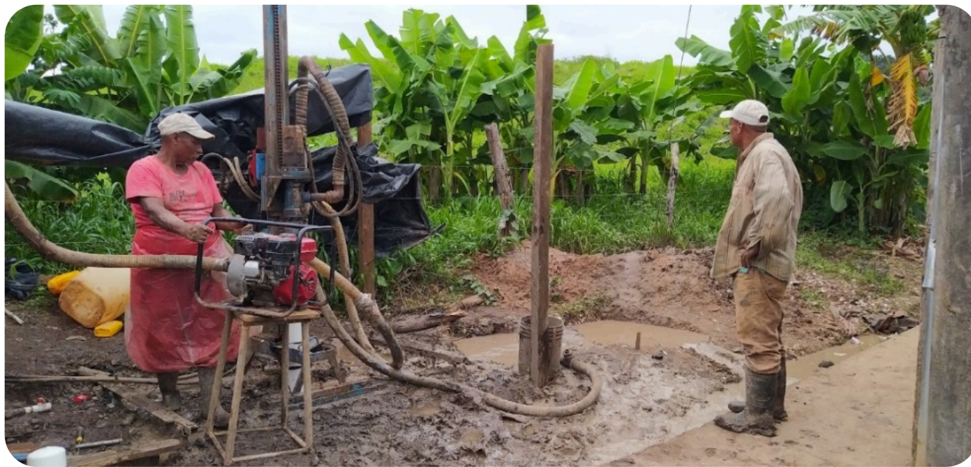
Forage du puits à Punta Masaya, Décembre 2023
